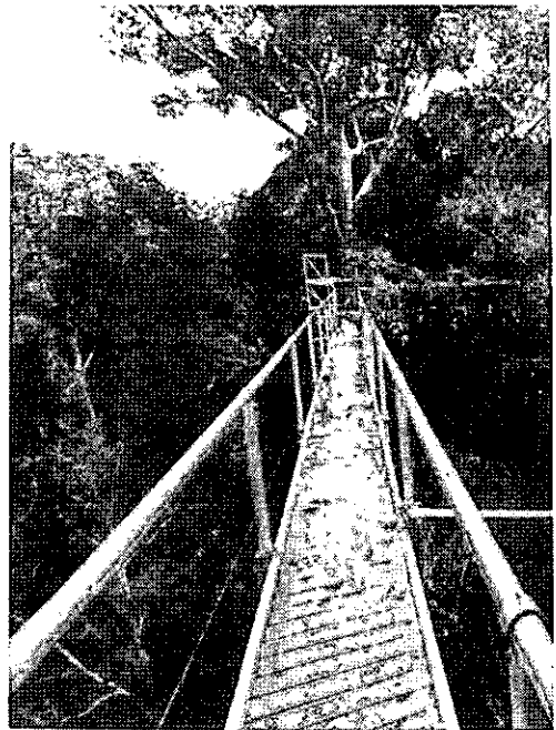
図6 タワー間を結ぶ橋の概要 橋には手すりも設けてあり、落下防止になっている。
