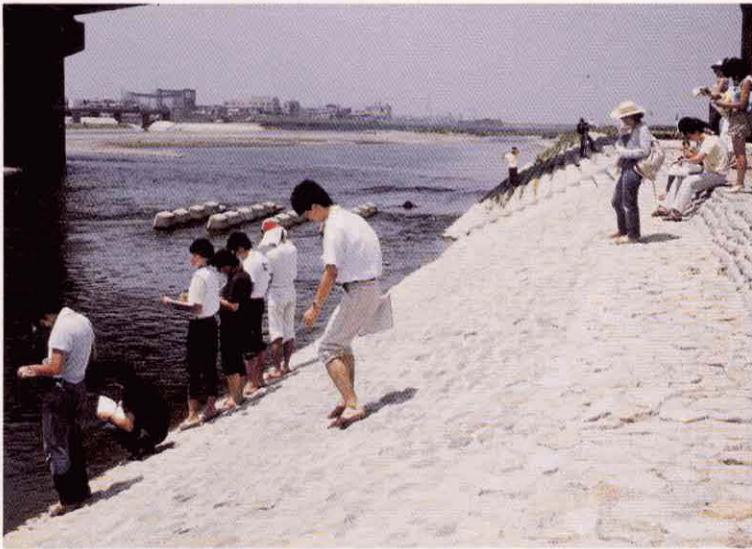
写真 4 多摩川新二子橋（地点4） Photo 4 Tama river by the Shinfutagobashi (Site 4)
