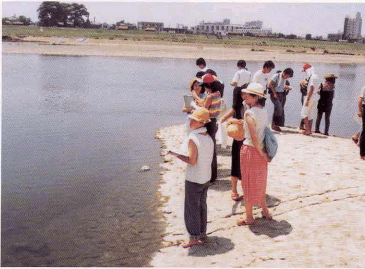
写真 5 多摩川兵庫島突出し護岸（地点5） Photo 5 Tama river at the Hyogoshima (Site 5)
